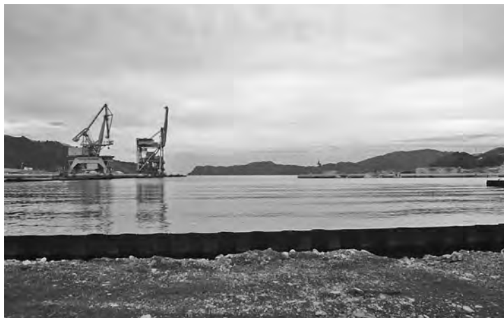
震災から二年九ヶ月。釜石港の仮の岸壁。(2013年12月11日) 写真 筆者
